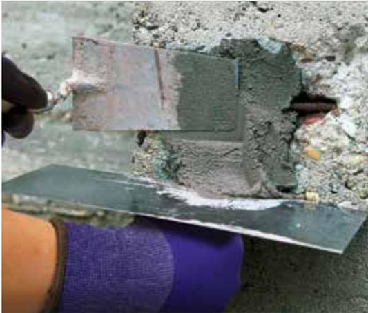
Mattfeucht vorgeässte Fehlstellen direkt mit DisboCRET® 507 oberflächenbündig reprofilieren. Es ist kein zusätzlicher Korrosionsschutz und keine Haftbrücke erforderlich.
